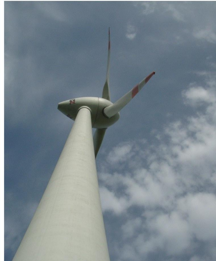
ハブ高さ120m, 羽根直径112m, 定格出力5MW
