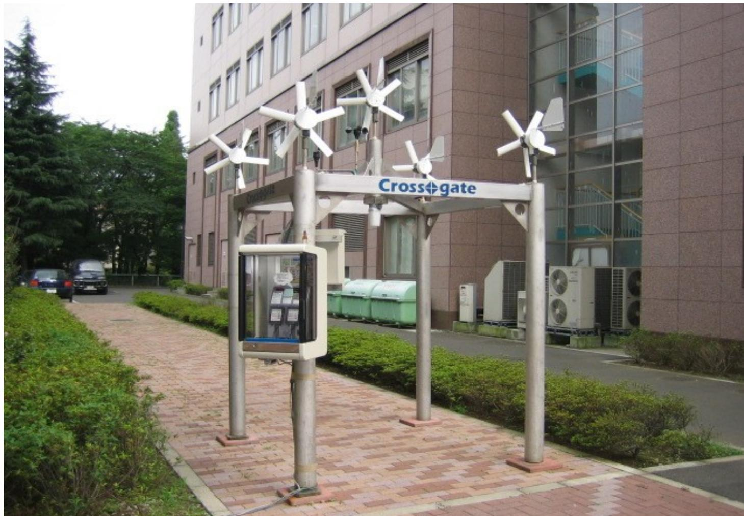
街に風車を！ 風力電気で携帯電話器を充電するクロスゲート（千葉大学）
