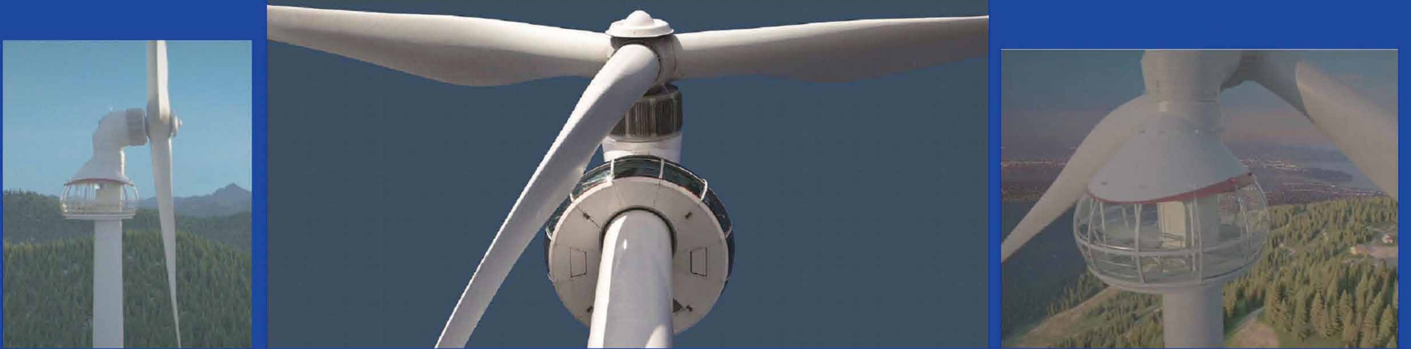
展望室付き風車／the Eye of the Wind／バンクーバー、カナダ／1500kW、ハブ高さ65m、翼直径77m
