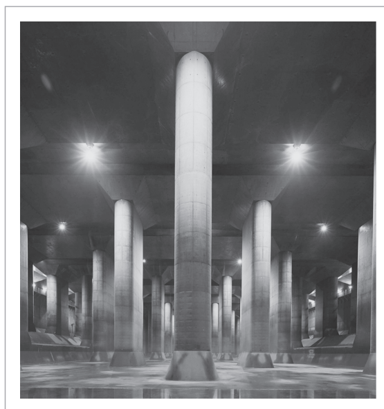
図1 / 巨大地下神殿のような首都圏(外郭放水路の内部)
