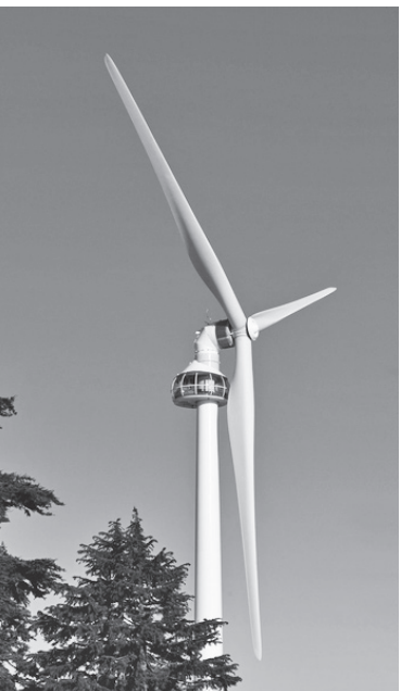
バンクーバーのグルースマウンテンに設置されている展望室付き発電風車(1500kW、エレベータで60mの展望室に搭上できる)
