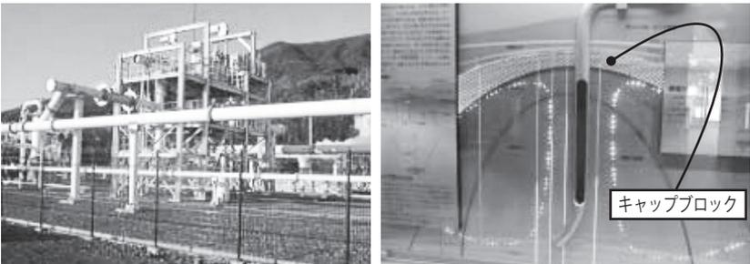
地熱発電所の地上部分（硫化水素除去装置）と地熱館のキャップブロックの解説画面。
