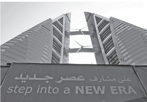
写真②：工事中のB WTCとビルトイン風車と、その看板（2008.1.6）
