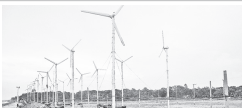
20kW風車が50基並び、クツブディア島のウインドファーム
